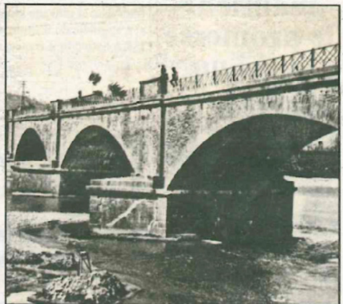
Qui sopra: Lavori al vecchio ponte tratto dall'archivio di foto Santuzza
